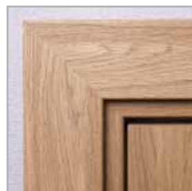
standardowe łączenie opasek pod kątem 45°
